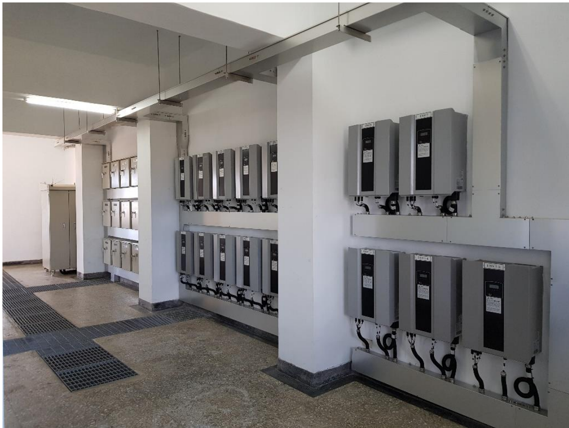
圖 5-10：七美島智慧微電網中所採用的智慧變流器
