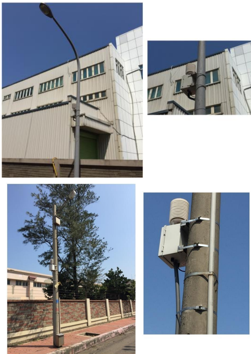
圖 3-5：金屬桿施工照片
